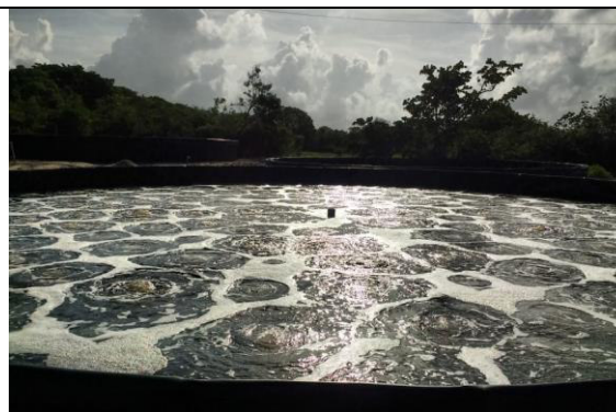
Figura 8: Tanque suspenso (200 m 3 ) em operação
