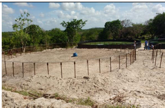
Figura 7: Tanque suspenso (200 m 3 ) em construção
