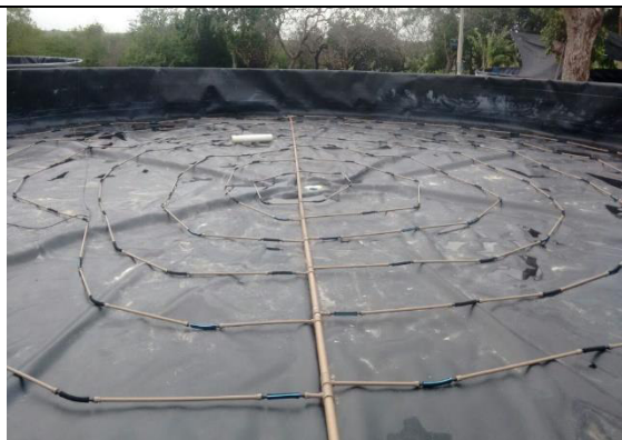
Figura 9: Manguerias porosas para aeração
